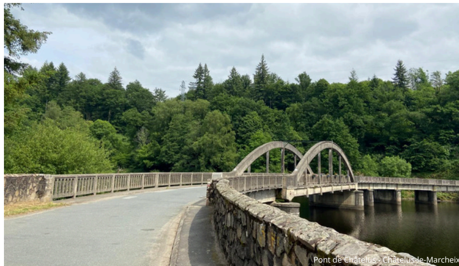
Pont de Châtelus - Châtelus-le-Marcheix
